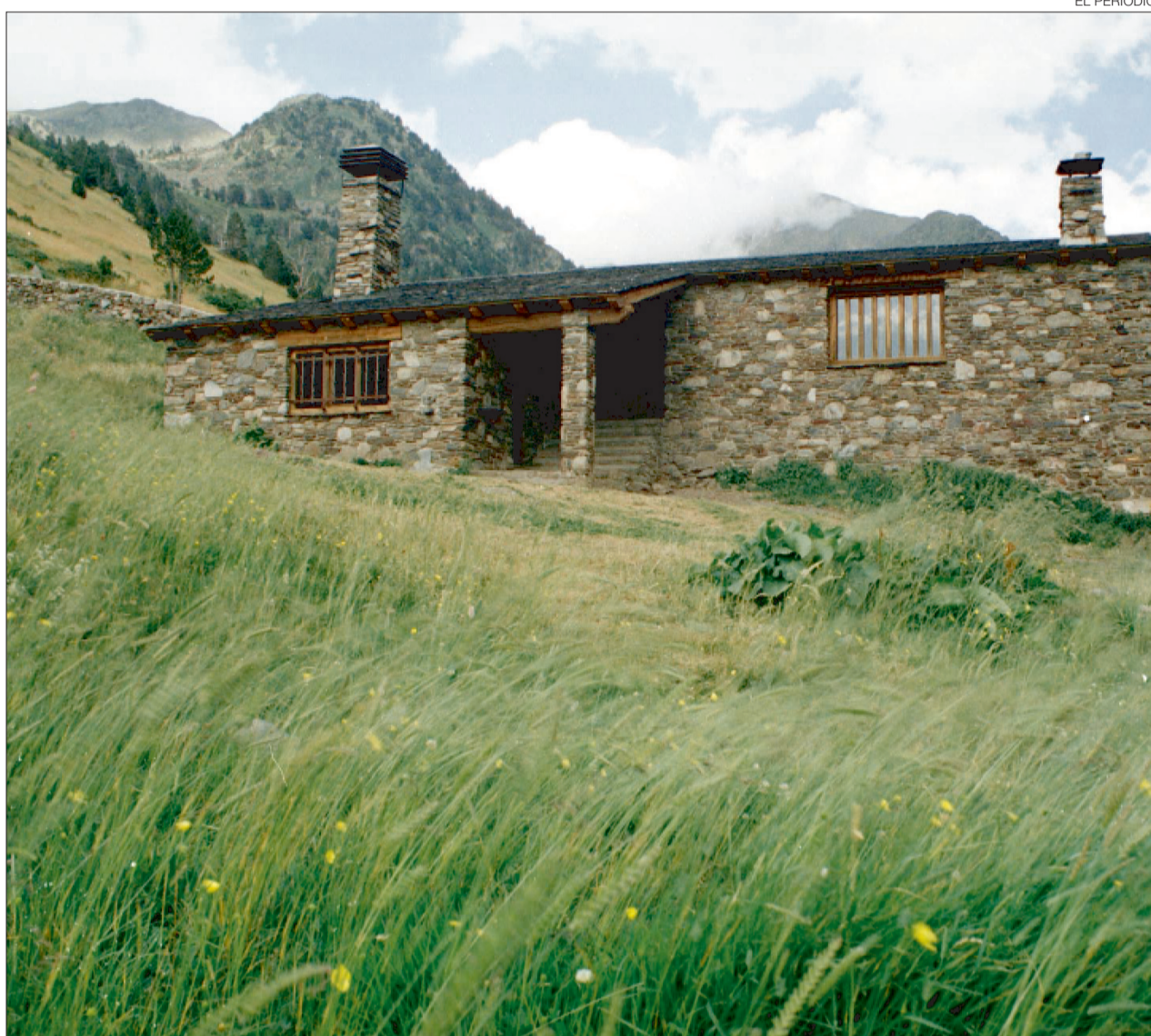
► Vista exterior de l'edifici de la Vall de Sorteny.
